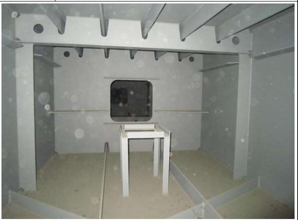
내용 전경 거더내부
