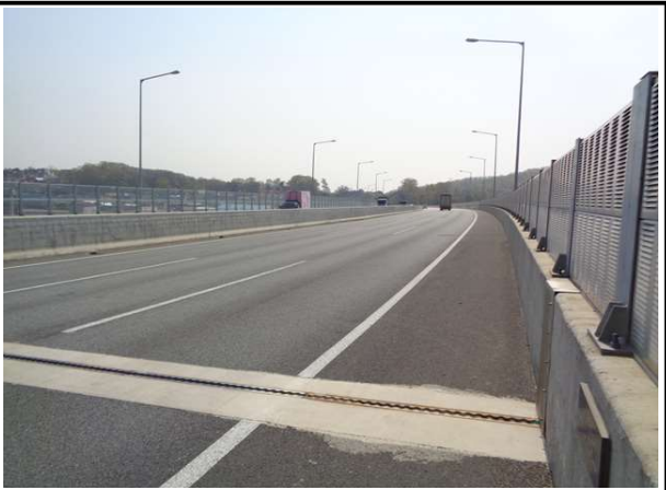
내용 전경 교면포장
